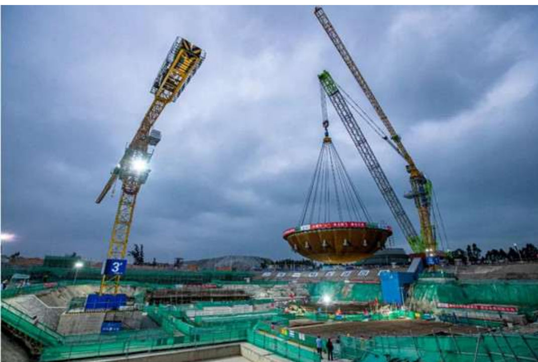
Construção do SMR ACP100 na usina nuclear de Changjiang. Localizado na província chinesa de Hainan, o ACP100 é um reator tipo PWR com potência de 125MWe.
