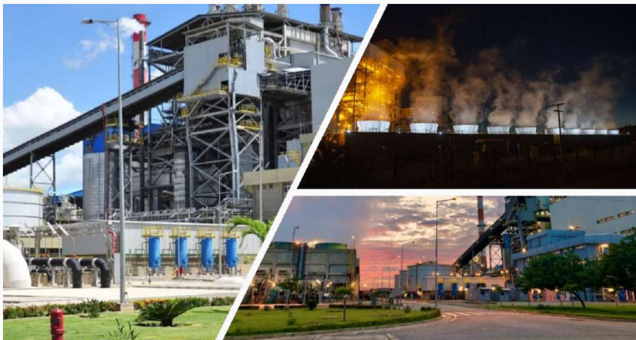
Complexo Termelétrico Porto do Pecém, São Gonçalo do Amarante – CE
