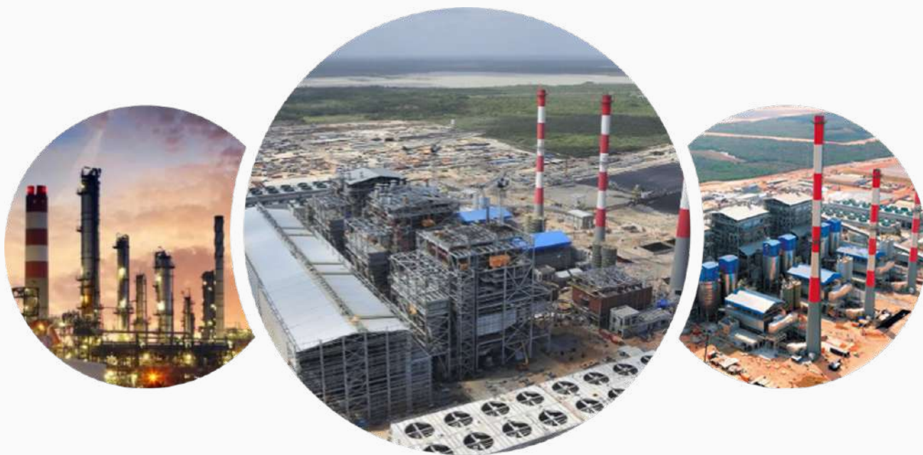
Usina Termelétrica Porto Itaqui, São Luís – MA Operador: Itaqui Geração de Energia S/A
