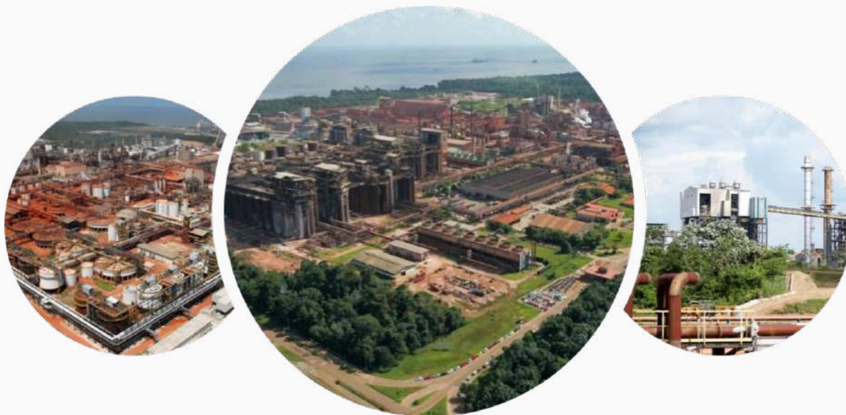
Usina Termelétrica Alunorte, Barcarena – PA Operador: Alumina do Norte do Brasil S/A
