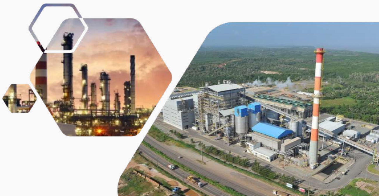
Usina Termelétrica Alumar, São Luís – MA
