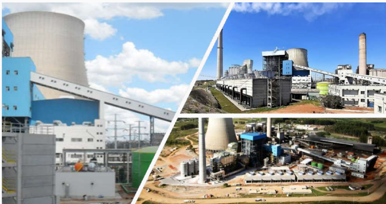
Usina Termelétrica Candiota III, Candiota – RS Operador: Âmbor Uruguiana Energia S.A.
