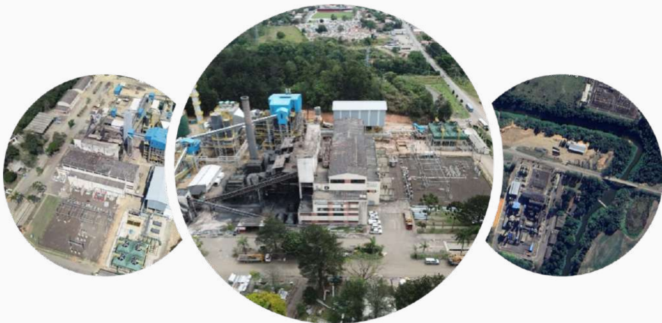
Usina Termelétrica Figueira, Figueira – PR Operador: Copel Geração e Transmissão S.A
