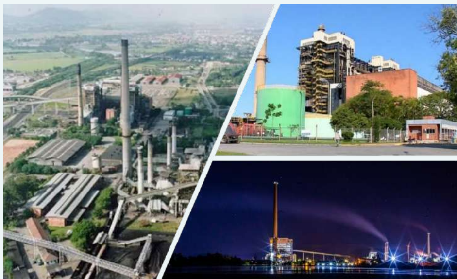
Complexo Termelétrico Jorge Lacerda, Capivari de Baixo – SC Operador: Diamante Geração de Energia LTDA
