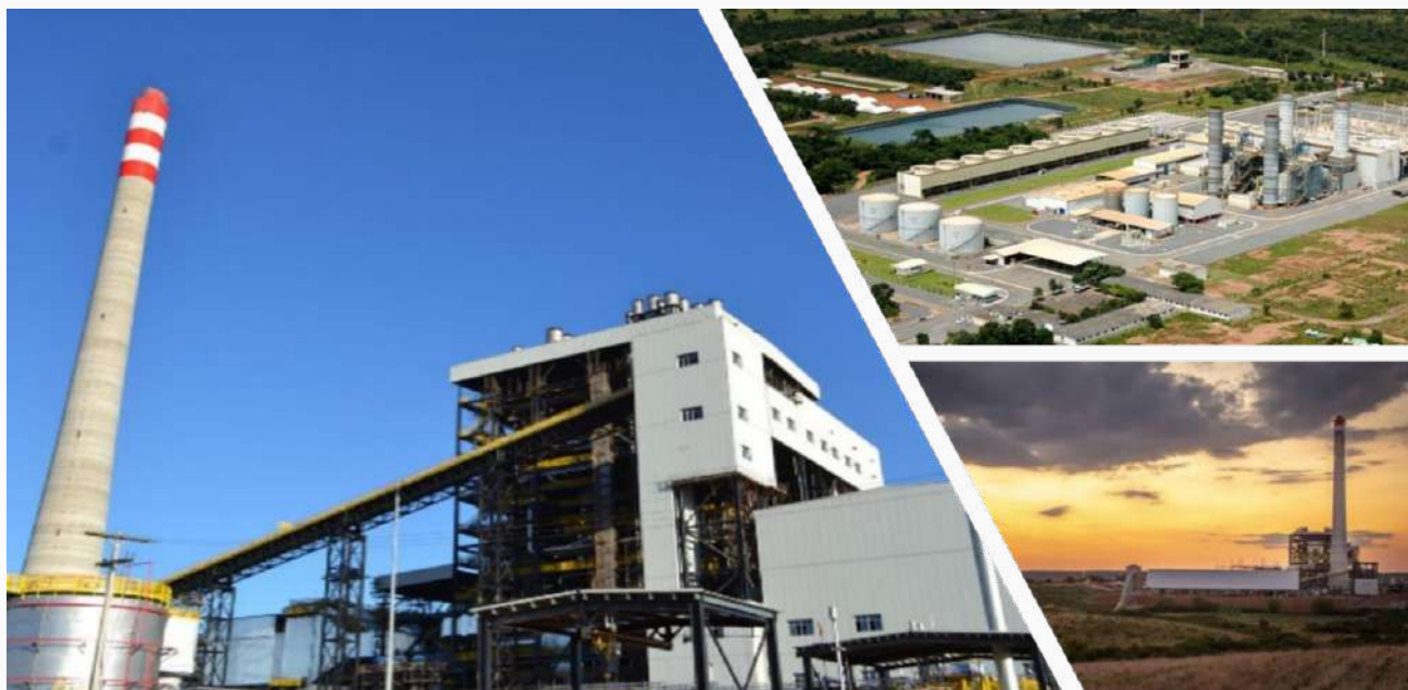
Usina Termelétrica Pampa Sul, Candiota – RS Operador: Usina Termelétrica Pampa Sul S.A
