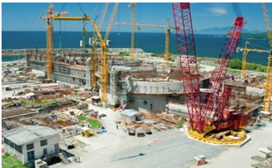
Figura 12: Obras para construção da Usina Nuclear Angra 3 Fonte: Eletronuclear, disponível em https://www.eletronuclear.gov.br/Paginas/default.aspx , acessado em 27/11/2020)
